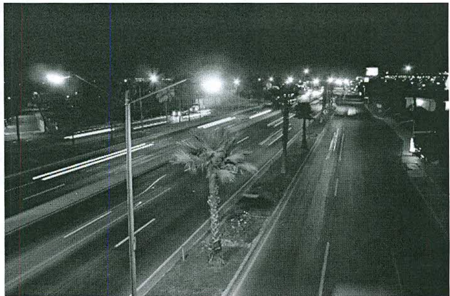
Figura 10. Percepción visual con luminarias de vapor de sodio a alta presión (VSAP).
