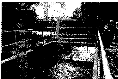
Fuente: Planta de Tratamiento Norte, descarga a un dren Federal. Inspección física de los auditores ambientales.
