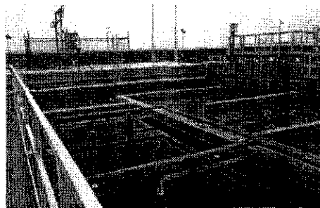
Fuente: Planta de Tratamiento Laguna de Patos, mostrando las cámaras de reparto. Inspección física de los auditores ambientales.
