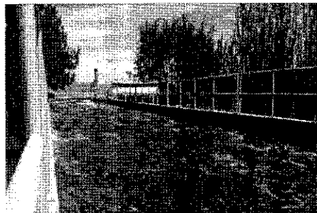
Fuente: Planta de Tratamiento Sur, la descarga es al Dren Federal denominado "interceptor norte". Inspección física de los auditores ambientales.
